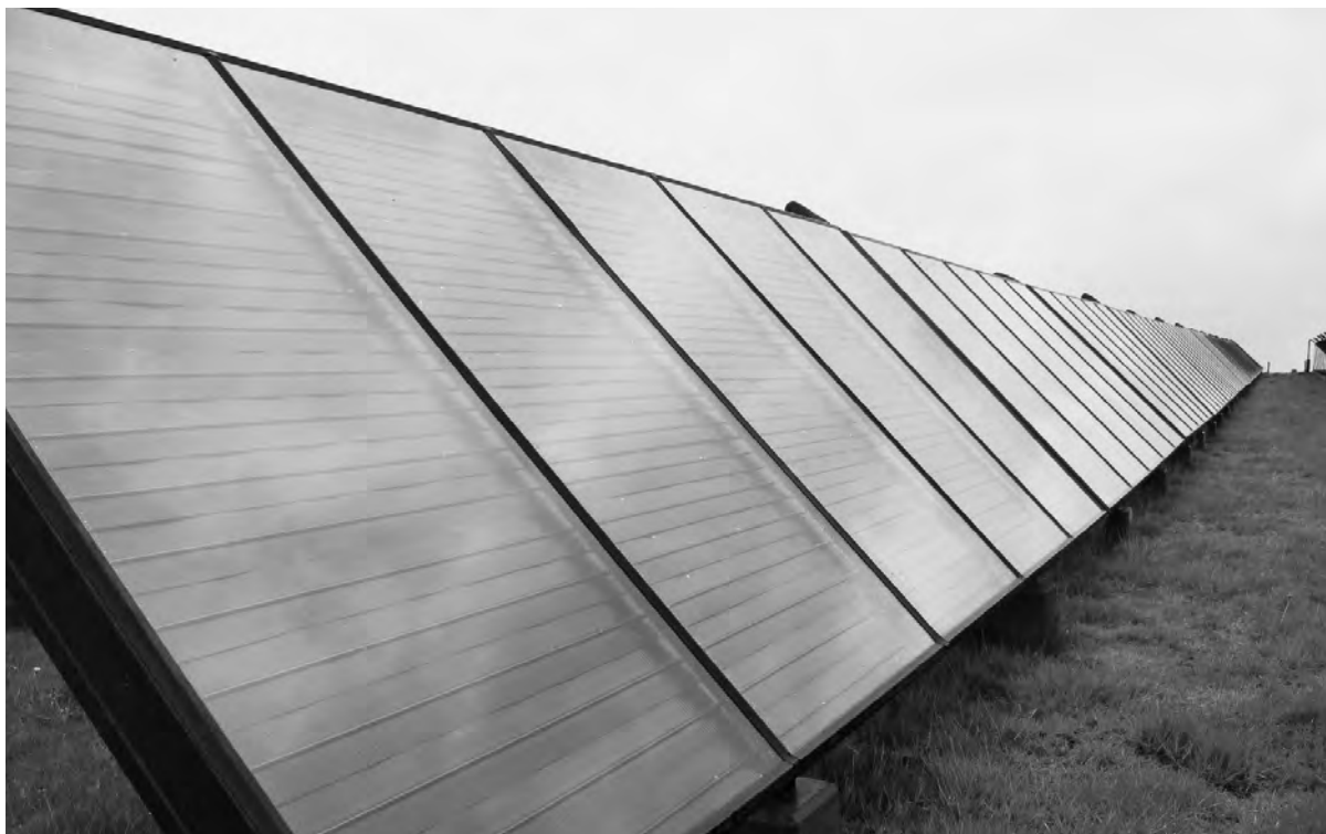
Solarthermie kann mit Freiflächenanlagen ganze Dörfer und Stadtteile mit Wärme versorgen. Foto: Neumann
