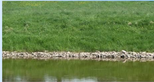
Steinschüttungen legen Uferlinie fest und verhindern naturnahe Flussuferentwicklung
