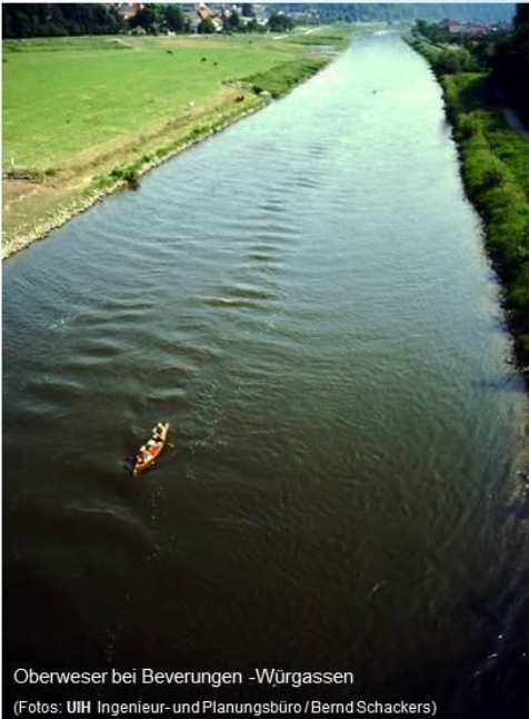
Steinschüttungen legen Uferlinie fest und verhindern naturnahe Flussuferentwicklung
