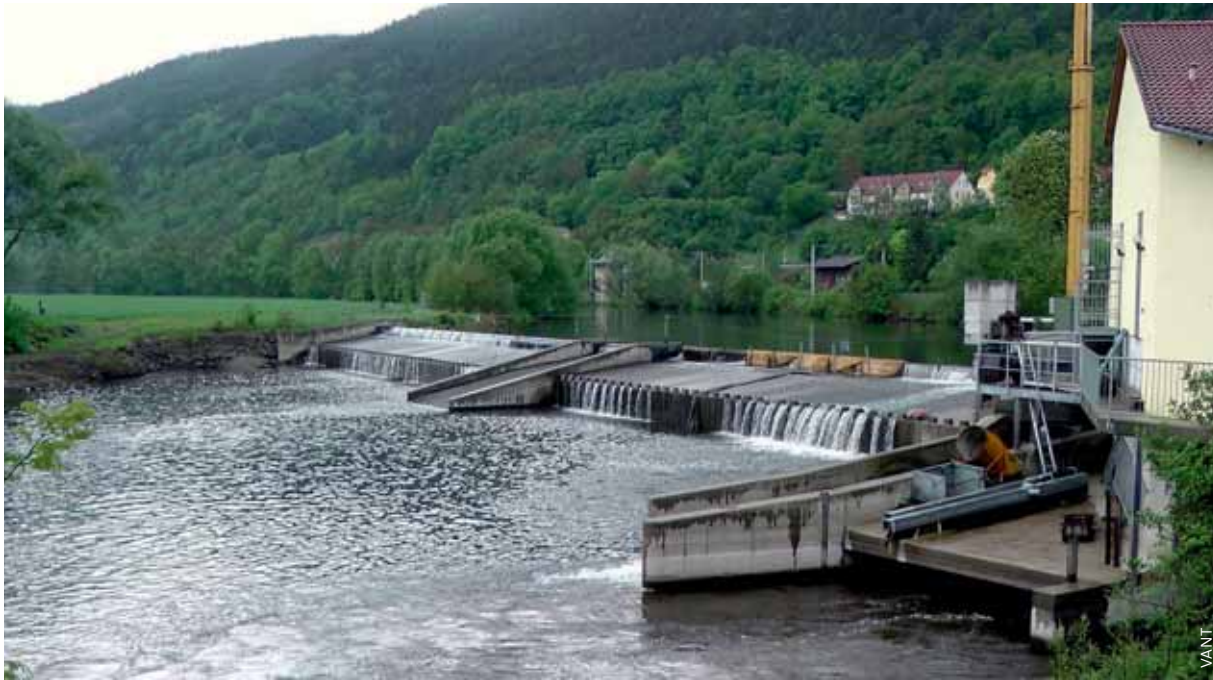
Flusskraftwerk Uhlstädt an der Saale – eines von 7300 kleinen Wasserkraftanlagen in Deutschland, die unter eintausend Kilowatt leisten.
