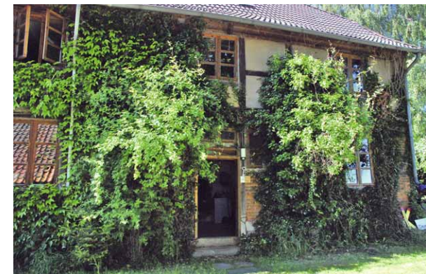
Das 200 Jahre alte Fachwerkhaus soll mit ökologischen Baustoffen saniert und gedämmt werden.
