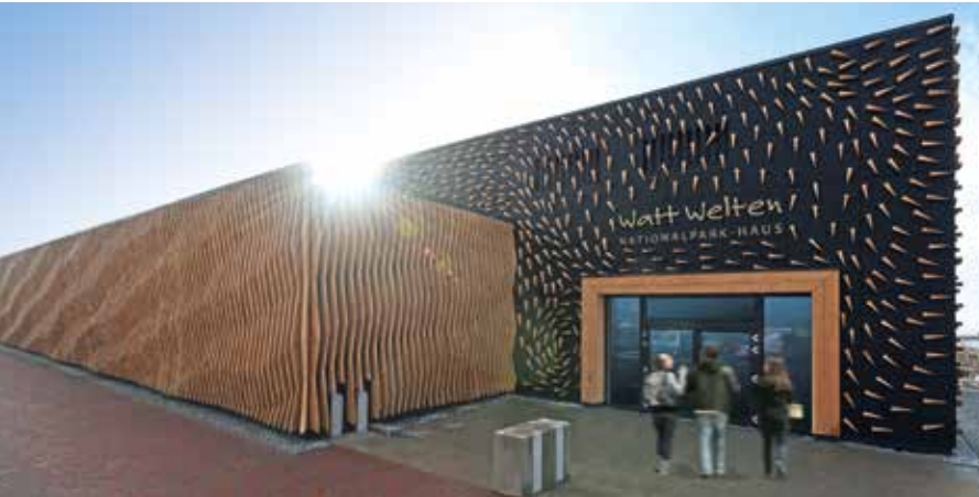
Außenansicht des neuen Nationalpark-Hauses „WattWelten“ auf Norderney. Foto: Nationalpark-Haus
